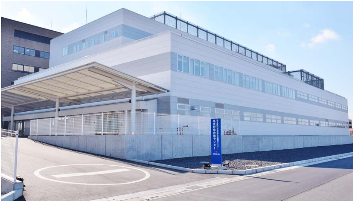
高度救命救急センター棟
